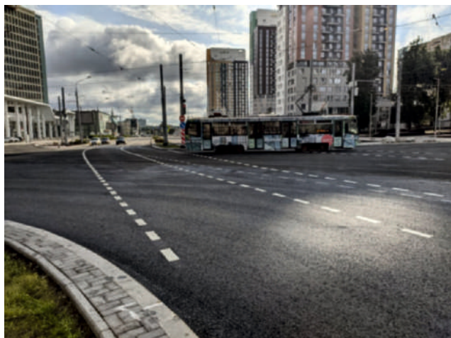
Рис. 2. Фотография реконструированного участка ул. Революции в г. Перми
